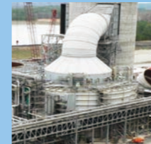
ジョージアパワー社(米国) ポーエン発電所CT-121排煙脱硫装置
