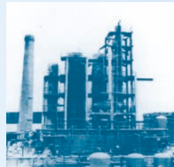
三菱石油 (現 JXTGエネルギー) 川崎製油所復旧工事
