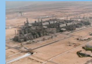
QATARGAS社(カタール) LNGプラント(トレイン1&2)
