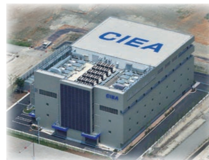
高度微生物統御を実現した世界的研究施設
