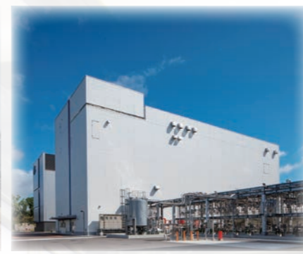
世界最大スケール特殊環状ペプチド原薬生産工場
