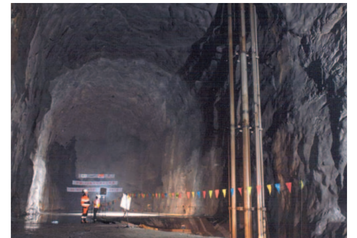
寧波華東BP液化石油氣有限公司 水封式岩盤LPG貯蔵基地
