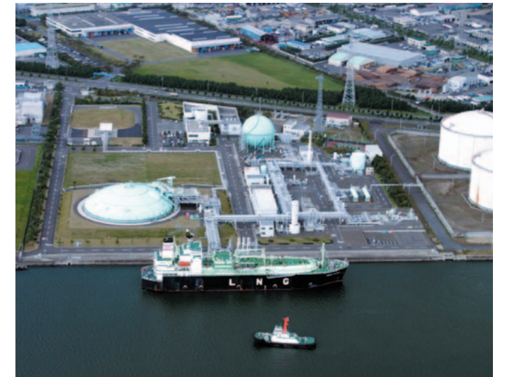
仙台市ガス局 仙台
