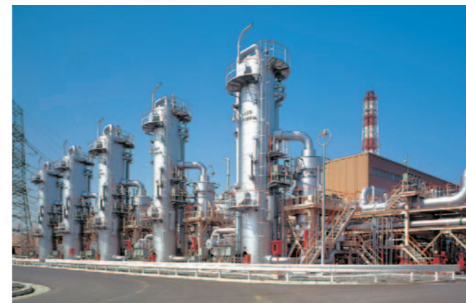
垂直サーモサイフォン式気化器
