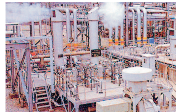
液中燃焼式気化器(SMV)
