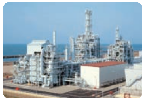
Japan-GTL実証プラント(新潟)
