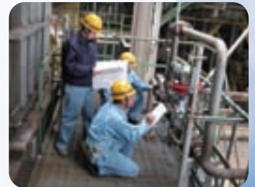
建設現場の品質管理風景
