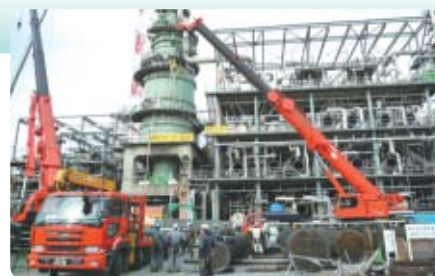
大型の定期修繕工事
