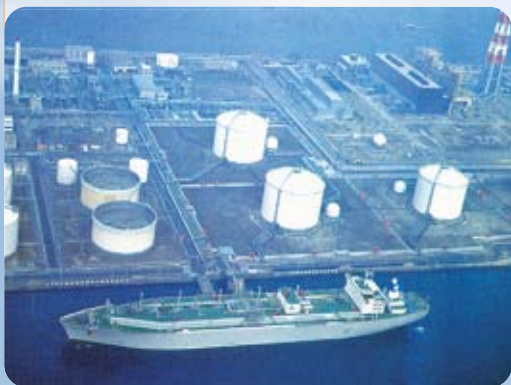
東京瓦斯(株)根岸 LNG基地
