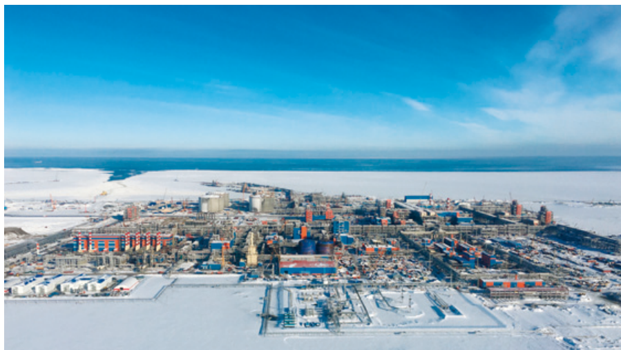
ロシア・ヤマルLNGプラント建設現場全景
