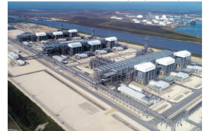
Freeport LNG Project, USA
