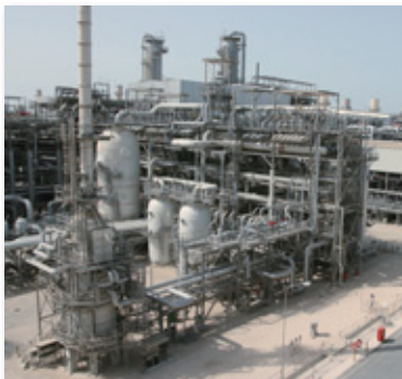
カタールガス2社(カタール) LNGプラント(トレイン4)
