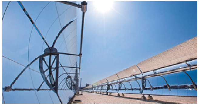
パイロットプラント集光設備(イタリア・シシリー島)
