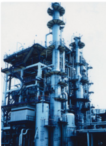
東亜石油(株)川崎軽油深度脱硫装置
