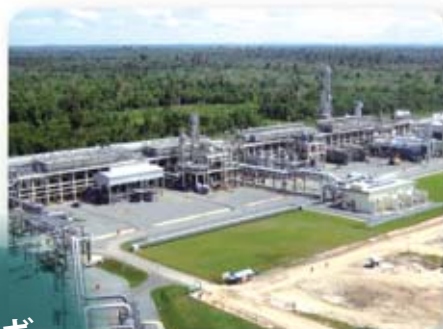
インドネシア向け天然ガスプラント
