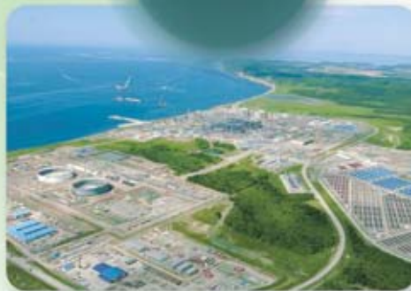
ロシア向けLNGプラント
