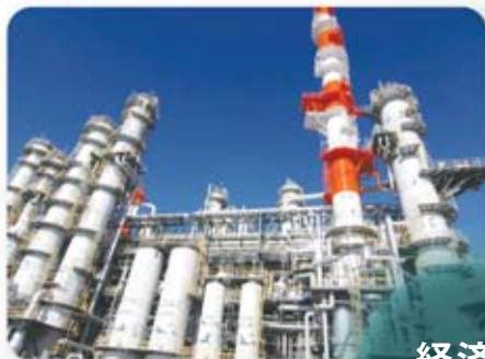
鹿島アロマティックス(株)向け石油化学プラント
