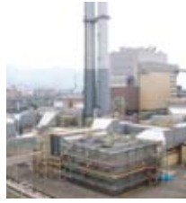
(株)神戸製鋼所向け 排煙脱硫プラント
