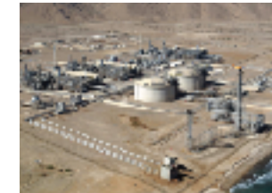
ガソリン、灯油、軽油や重油などを製造する石油プラントや製油所的设计・建設
