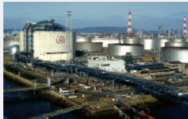
LNG受入基地
