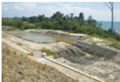
現場に設置した沈砂池
