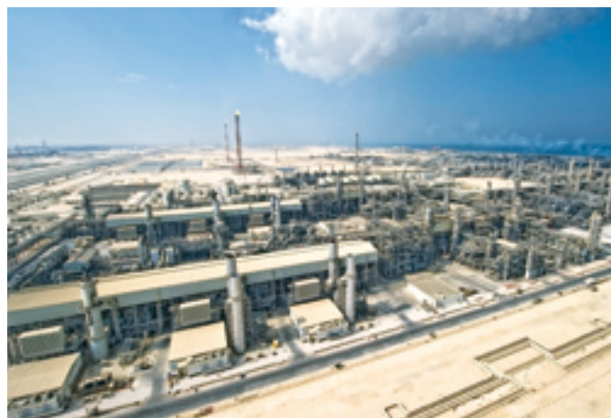
世界最大、年産780万トン×2系列のカタールLNGプラント (写真提供:カタールガスオペレーティングカンパニーリミテッド)
