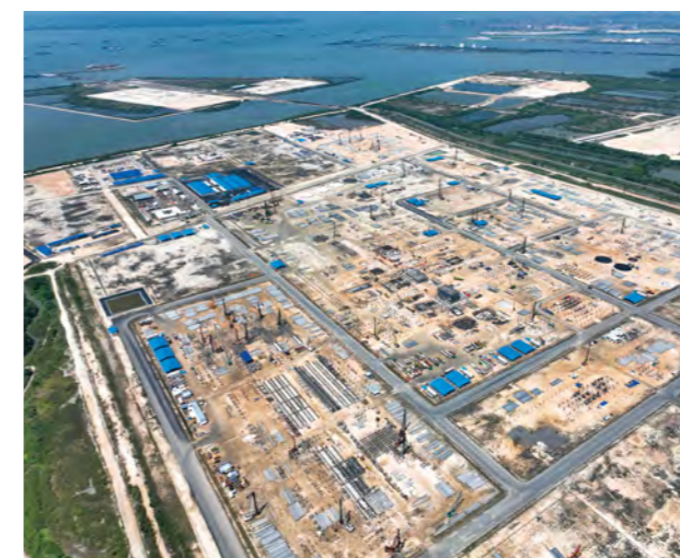
プラント全景(建設中) Courtesy of PT. Freeport Indonesia
