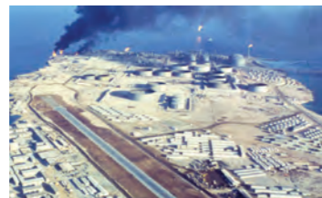
1976年 アブダビ液化ガス社(アラブ首長国連邦) アブダビ・ダス島 LNGプラント完成
