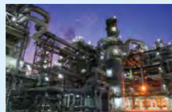
2004 カタールガス3&4社向けLNGプラント受注
