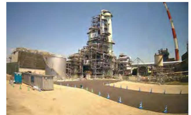
CCS事業の実証設備建設工事
