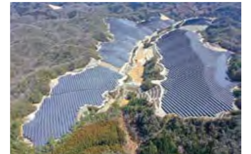
パシフィコ・エナジー(株)向け豊田メガソーラー発電所
