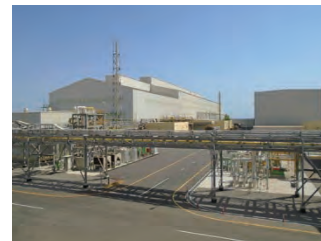
完成したスポンジチタン製造工場
