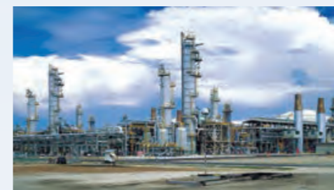
プラタミナ(インドネシア) アルン天然ガス液化プラント
