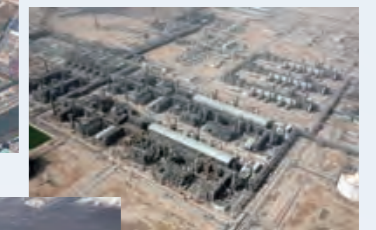
カタールガスオペレーティング カンパニーリミテッド(カタール) 天然ガス液化プラント
