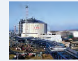
水島エルエヌジー(株) 水島LNG受入基地
