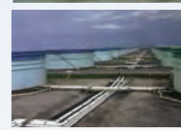
福井国家石油備蓄基地
