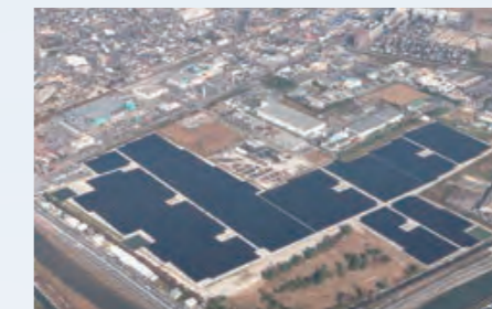
三井物産(株)太陽光発電設備
