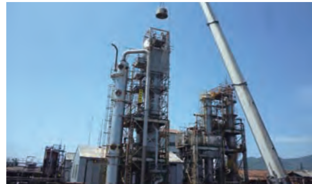
復旧工事の風景
