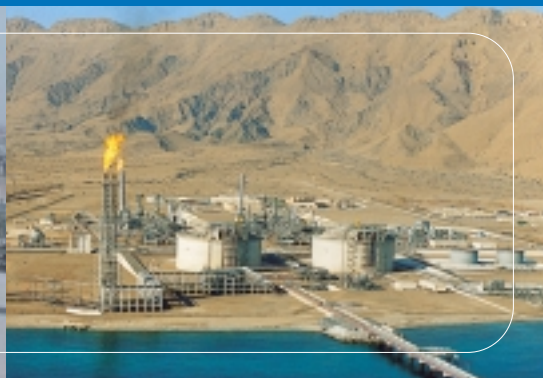
LNG Plant (3,300,000 t/y x 2) Oman LNG L.L.C. (Qalhat, Sultanate of Oman)
