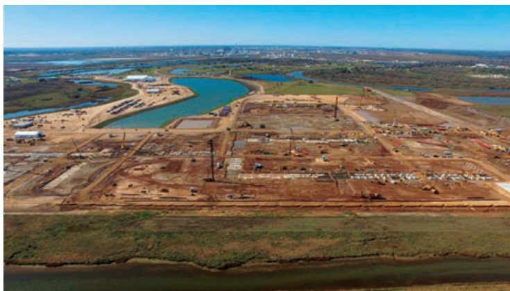
米国フリーポートLNGプラントの現場全景
