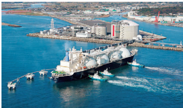
完成した日立LNG基地
