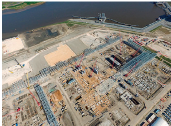
建設の始まった米国のキャメロンLNGプラント
