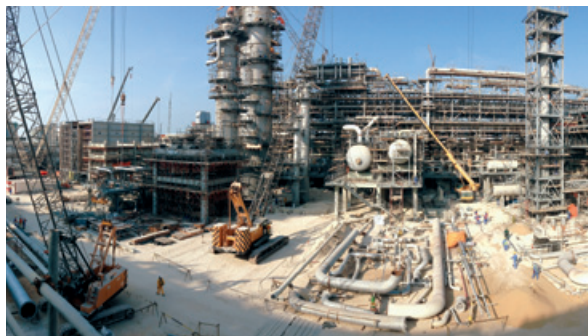
進捗するカタールのラファンリファイナリー拡張工事
