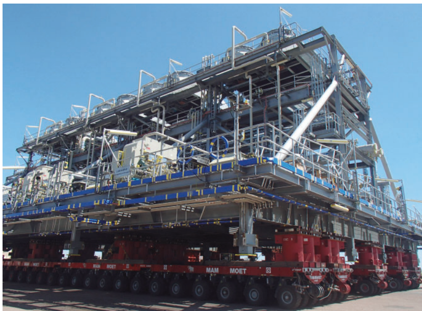
イクシスプロジェクトの陸上LNG設備・現場に搬入された大型モジュール (オーストラリア連邦北部準州ダーウィン、プレイディンポイント)
