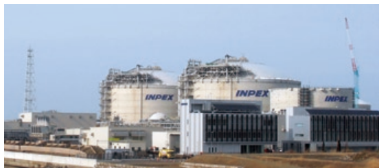
完成した直江津LNG基地全景 写真提供:国際石油開発帝石株式会社 (INPEX)
