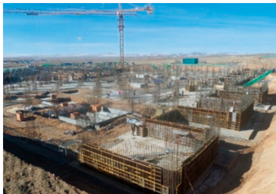
現場写真（旅客ターミナルビルエリアの基礎工事）
