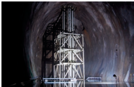
（上）波方基地全景 （下）地下貯槽内金属管据付状況（地下150～180メートルの岩盤に幅26メートル、高さ30メートル、長さ450メートル前後の巨大なトンネル3列からなる貯槽を設けています） （写真提供：JOGMEC）
