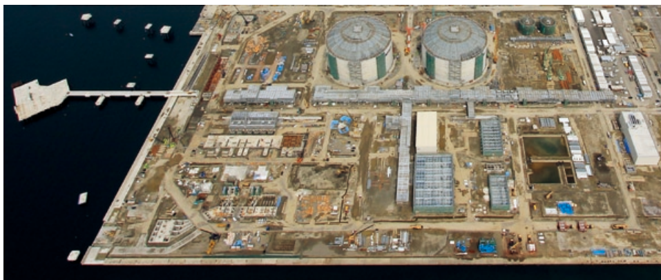
直江津LNG受入基地全景 写真提供：国際石油開発帝石㈱
