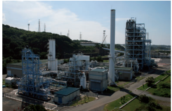
多目的石炭ガス製造技術開発(EAGLE)全景
