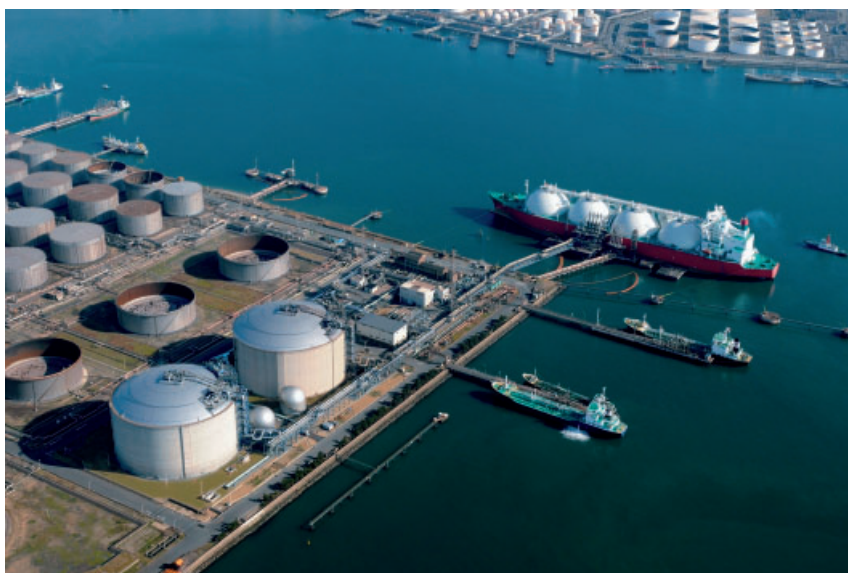
写真手前が2基目（増設）LNGタンク 写真提供：水島エルエヌジー（株）
