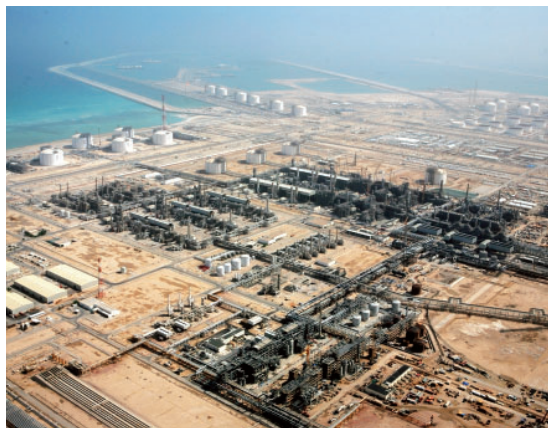
カタールガス既設設備とカタールガス2社向けプロジェクト全景
