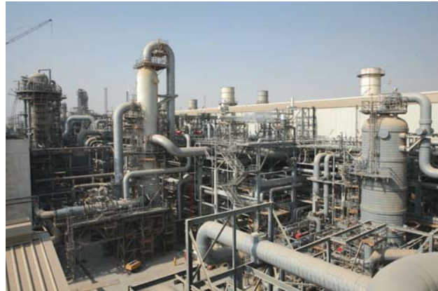
完成期を迎えるカタールのLNGプラント
