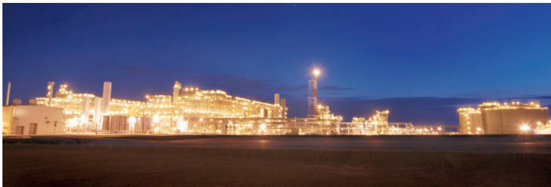
完成したサハリンのLNGプラント（写真提供：サハリン・エナジー・インベストメント社）
