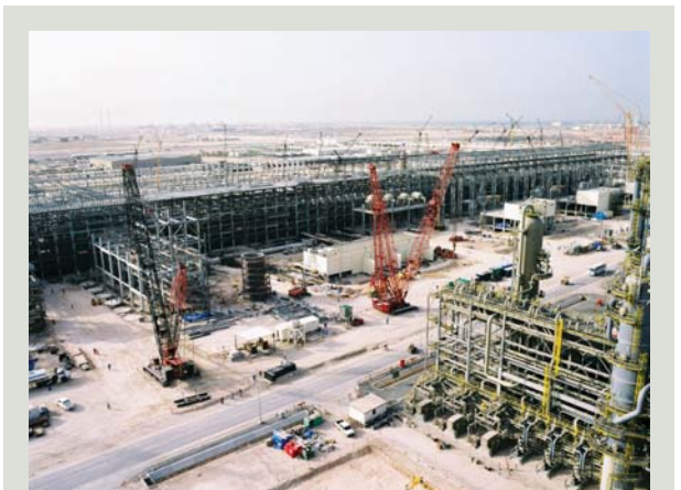
カタールで建設中のLNGプラント
