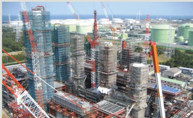
建設中の鹿島アロマティクス(株)アロマコンプレックス新設工事
