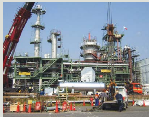
建設中の三菱ガス化学(株)MXDA設備建設工事
