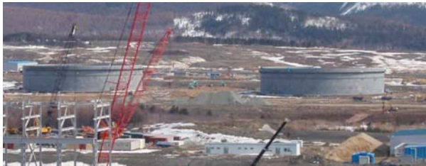
冬季に進むLNG貯蔵タンク建設工事
