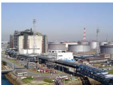
建設中の水島LNG基地
