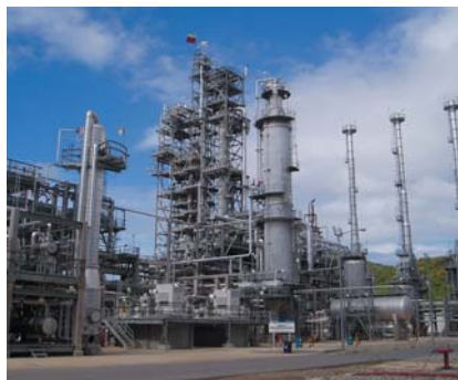
ベネズエラ向け製油所拡張プラント
