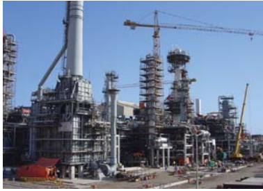
建設中のオマーン向けLNGプラント
