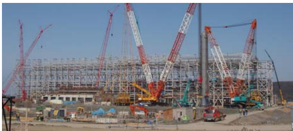
順調に進むメインパイプライン据付工事
