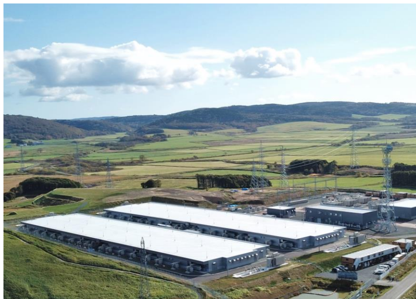
蓄電池システム建設現場
